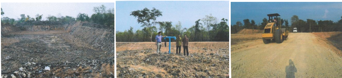
ภาพ 9 สถานที่กำจัดขยะมูลฝอยเทศบาลตำบลเวียงใหญ่แบบเทกองควบคุม หลังการปรับปรุง
