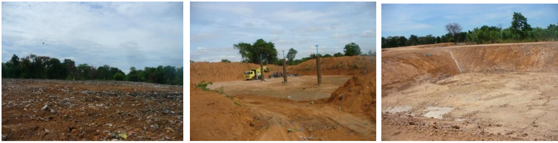
ภาพ 11 สถานที่กำจัดขยะมูลฝอยเทศบาลตำบลชนบทแบบเทกองควบคุม ภายหลังการปรับปรุง
