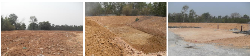
ภาพ 5 สถานที่กำจัดขยะมูลฝอยเทศบาลตำบลโนนศิลาแบบเทกองควบคุม หลังการปรับปรุง
