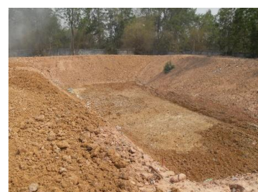
บ่อน้ำบาดหรือเก็บกักน้ำชะขยะ
