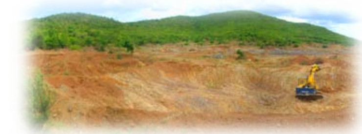
การขุดตักดินลูกรังและหินผุบริเวณพื้นที่เนินเขา ต.ดอนตาเพชร อ.พนมทวน จ.กาญจนบุรี
